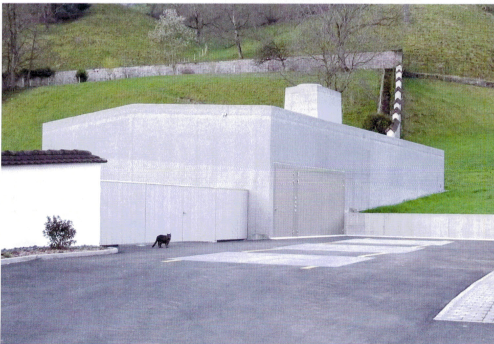
Zwei Drittel des Heizwerks in Stans befinden sich im Untergrund und verkleinern dadurch das Erscheinungsbild. (Bild: IS SaveEnergy AG)
